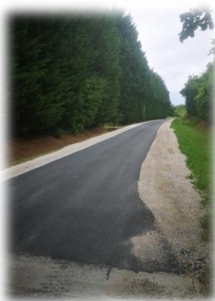
Réfection de la route de Saffais
