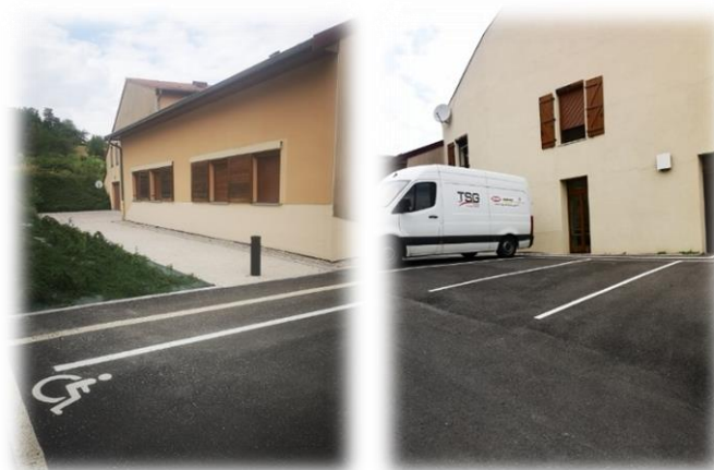
Mise en accessibilité de la salle du Pressoir et de la mairie
